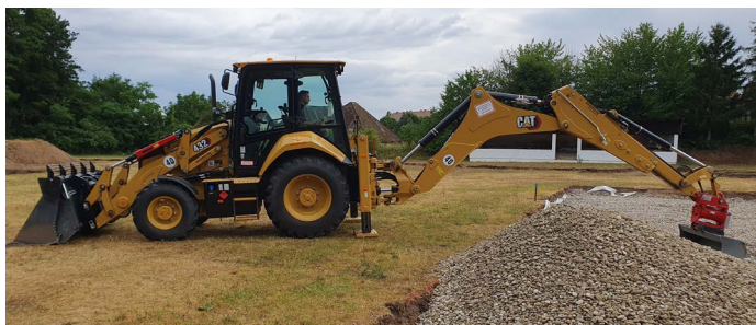
Die Stadtwerke arbeiten oft mit großem Gerät.
